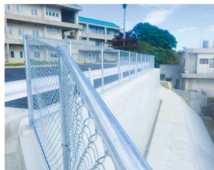
北中城小学校擁壁整備工事
