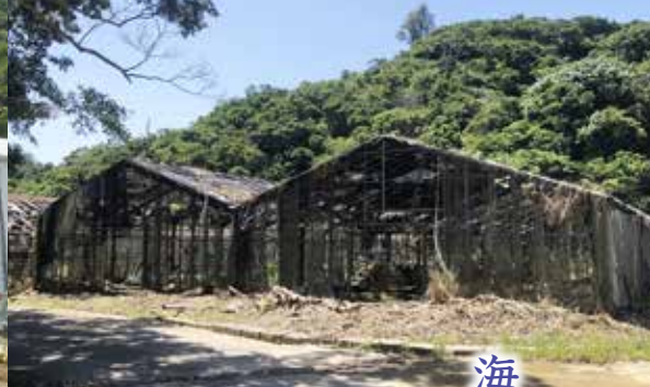
ハウス修繕前
