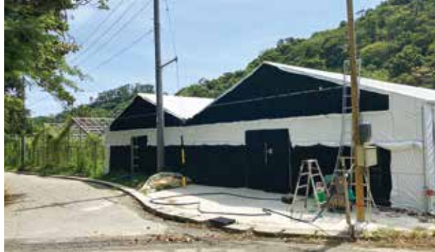
ハウス修繕後
