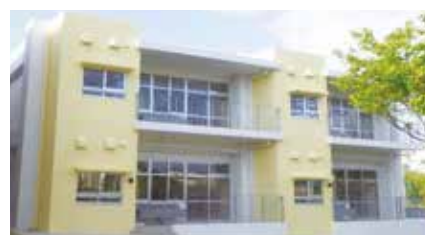
島袋小学校校舎増築工事 (令和4年度工事完了)
