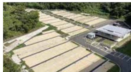
公営墓地納骨堂新築工事 (令和3年度工事完了)
