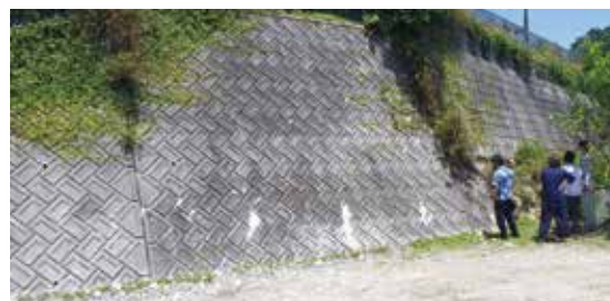
北中城小学校の南側擁壁
