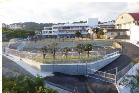
中学校外構工事(全景)
