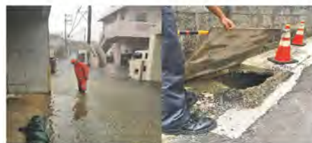
▲島袋地区排水路整備工事
