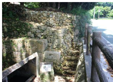
大城イリヌカー石積 修繕工事
