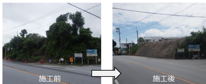
島袋地内村有地土砂災害応急工事
