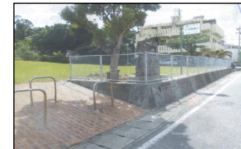
フェンス修繕（あおい公園）
