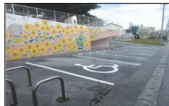
駐車場車止め設置 （喜舎場保育所）
