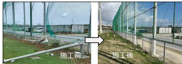
台風被害フェンス修繕（しおさい公園）
