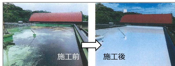
校舎防水工事（島袋小学校）
