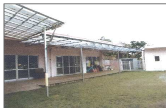
日よけ屋根設置工事 （喜舎場保育所）
