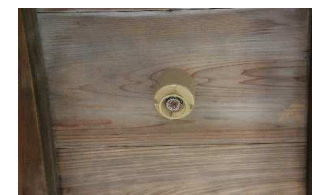
スプリンクラー設置
