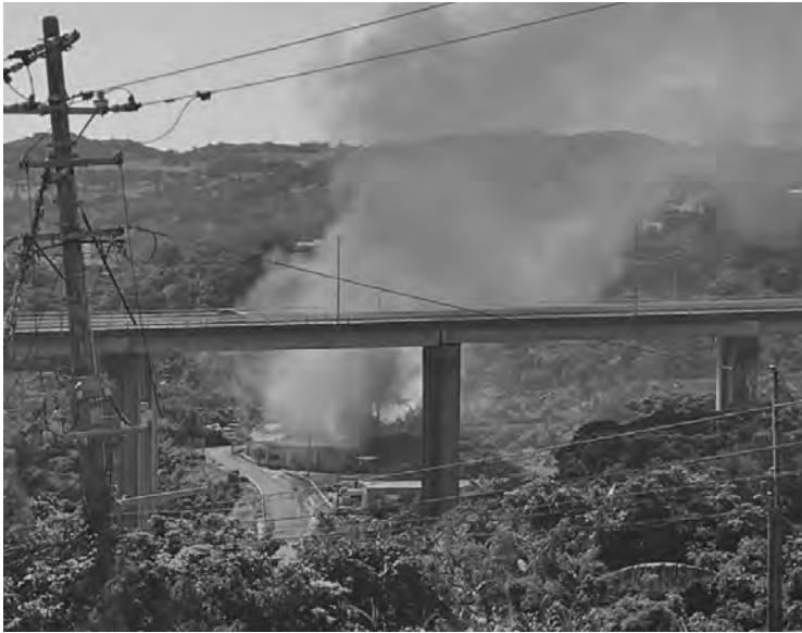
村内で起きたヤード火災
