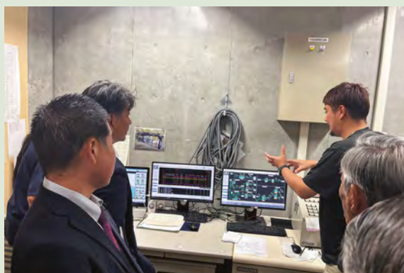
①村水道事業施設 中央監視システム視察
