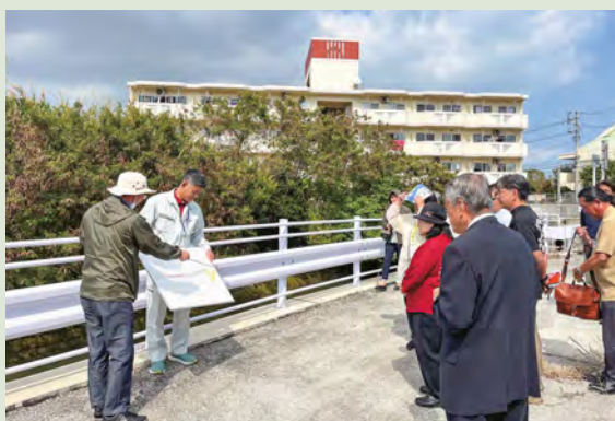
③村道北中城高校127号線 道路護岸整備工事現場視察
