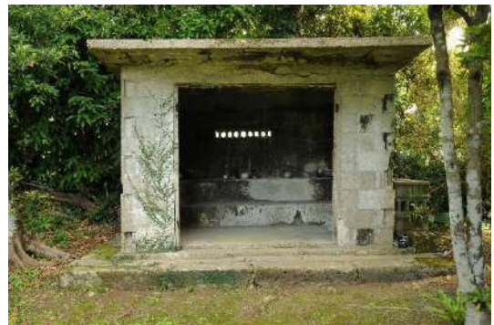
■ 喜友名根所 改修前の外観
