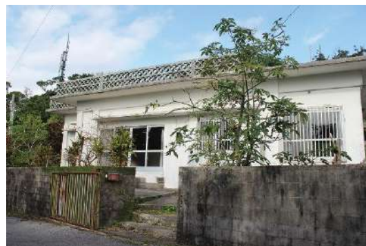
■久知屋根所 外観（母屋）
