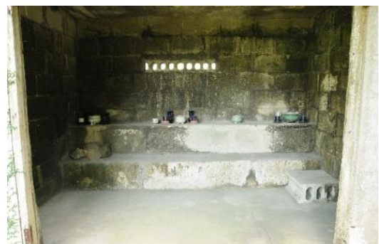
■ 改修前の内部の壇
