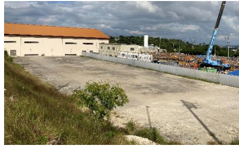
(対象敷地：南東側からの視点)
