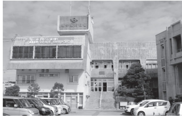
解体される旧役場第一庁舎 解体後、駐車場になる
