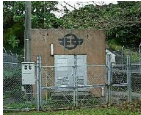
ポンプ施設の更新
