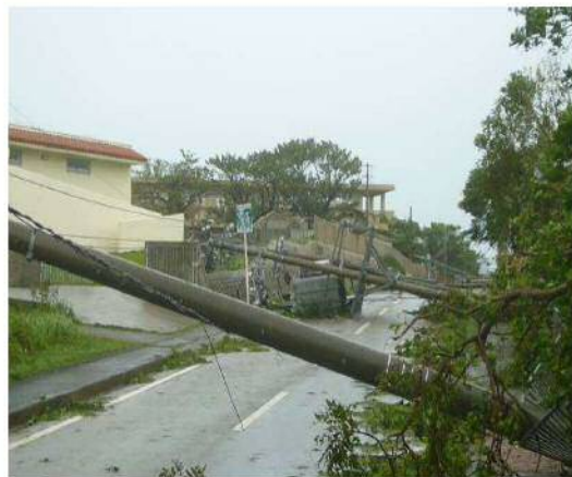
図 2-2 平成 18 年 台風 13 号（石垣市）
