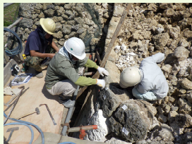
石垣補修工事の様子
