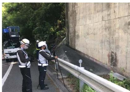
画像計測技術を用いた点検状況
