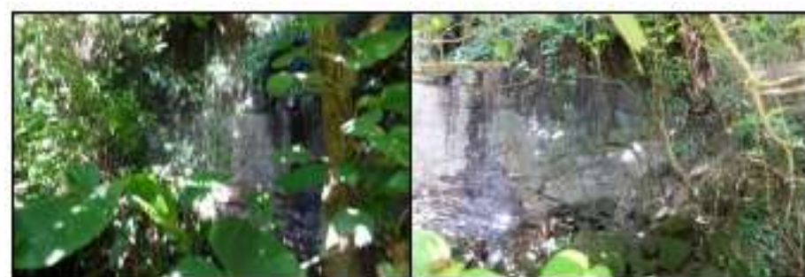
岩が露出しており現状を維持する箇所
