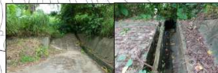
既存のスロープ階段部分。S ロープ沿いの側溝内に雨水利用の既設管が有ることから、この利用者との調整が必要と思われる。（道路の奥部にタンクがある）
