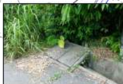
既存の雨水排水側溝 U600
