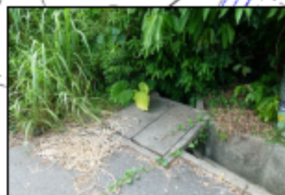
既存の雨水排水側溝 U600
