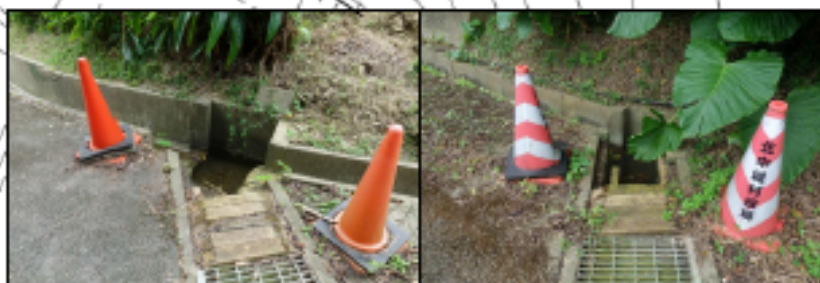
既存の雨水排水側溝。(U300、U450、U600 が敷設されている)
