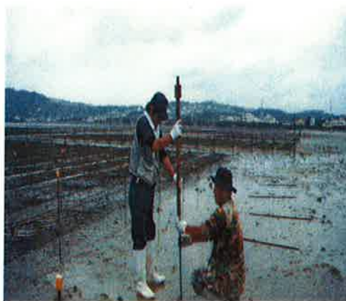
「アーサ鉄筋設置」
