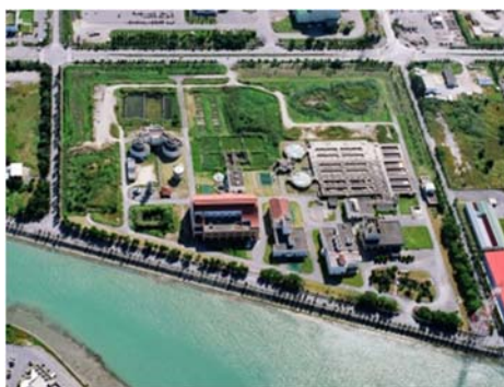
図 3-4 みずクリン具志川（具志川浄化センター）の外観
