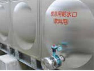
受水タンクには、断水や停電の際にも槽内の水を飲料用に利用できるように、緊急用給水口を設置しています。
