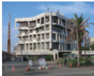
4月16日熊本地震（本震）により大きく損壊した宇土市役所庁舎（H28.6.28撮影）
