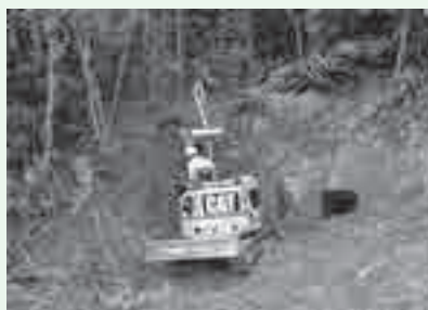
②重機による掘削
