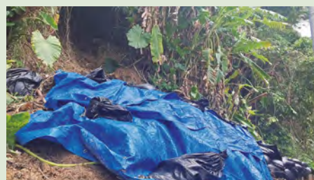
喜舎場地内の土砂災害現場
