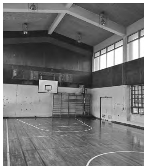
エアコンが設置されていない児童館内
