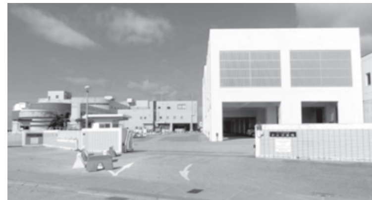
1日の配水量約15万㎡の北谷浄水場
