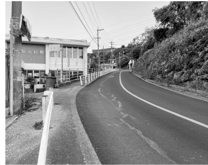
危険な箇所が多い村道1号線
