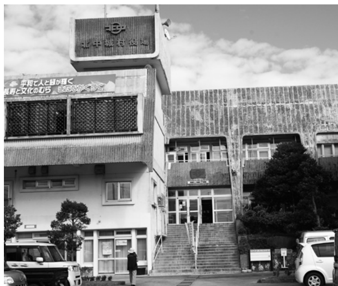
村民が待ち望んでいる新庁舎建設
