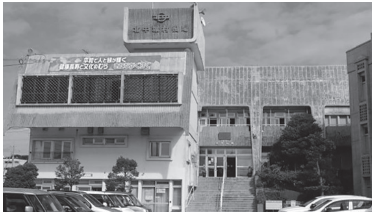
築47年経過した役場庁舎、老朽化が進み早期の改築が待たれている。
